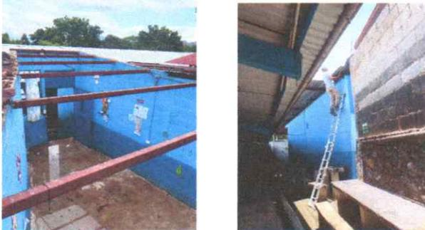
Foto 5: Techo en tres aulas en mal estado y goteo de agua en tiempos de lluvia.
