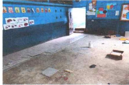
Foto 2: Piso de aula de preprimaria en proceso de reparación, sustitución / piso ceramico.
